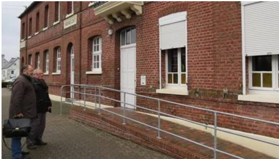
Le bâtiment mairie-école sera rénové.
