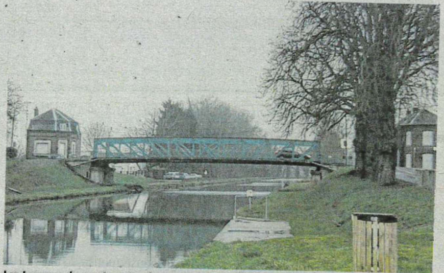
Les travaux du pont sont prévus cette année. Un chantier d'envergure.
