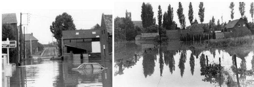
Figure 18 : Abancourt sous les eaux le 12 juillet 1995
