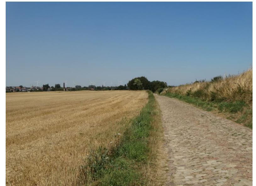
Figure 13 : Exemple de voie pavée : route départementale RD134 au sud de Saint Vaast-en-Cambrésis
